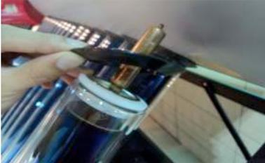
Перед установкой вакуумных трубок наденьте на стеклянную трубку черное силиконовое кольцо; для эффективности теплопередачи медный наконечник тепловой трубки, выступающий из вакуумной трубки, смажьте термопастой, а для удобства монтажа верхнюю часть стеклянной трубки (примерно на 5-7 см) смажьте жидким мылом.
