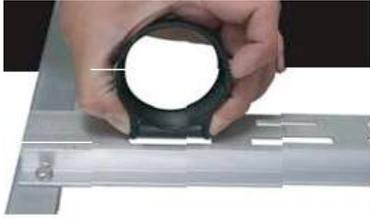
Установите черные круглые пластиковые кольца для крепления вакуумных трубок на горизонтальную планку с отверстиями для крепежа, расположенную в нижней части рамы.
